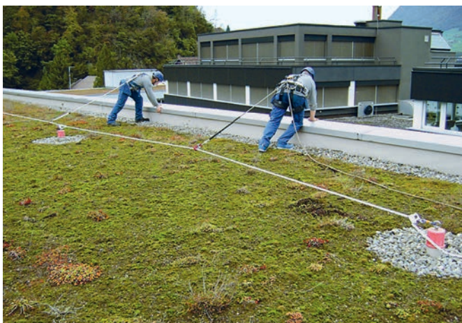
Abb. 10: Temporäres Seilsystem mit Karabinerhaken an EAP befestigt
