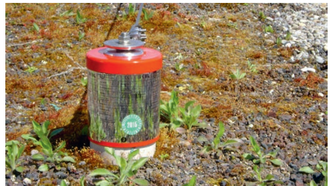
Abb. 25: Objektspezifische Anlagebeschriftung mit Prüfvignette
