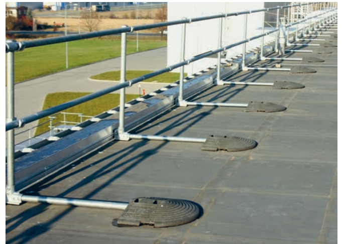
Abb. 16: Ausstattungsstufe 3: Seitenschutzsystem mit Auflast
