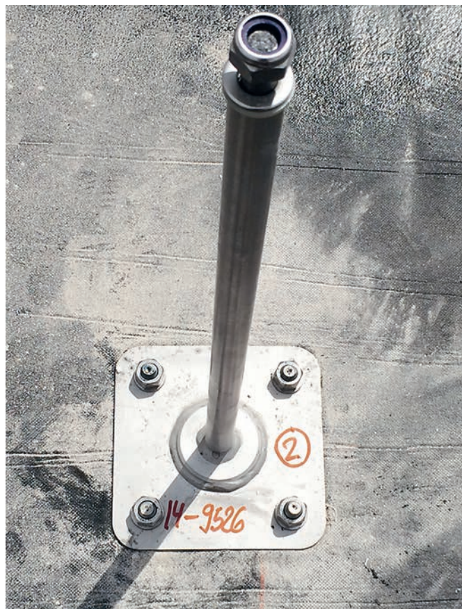
Abb. 23: Befestigungspunkt fertig montiert und für das Protokollfoto beschriftet mit Jahreszahl, der Objektnummer des Herstellers und einer fortlaufenden Nummer
